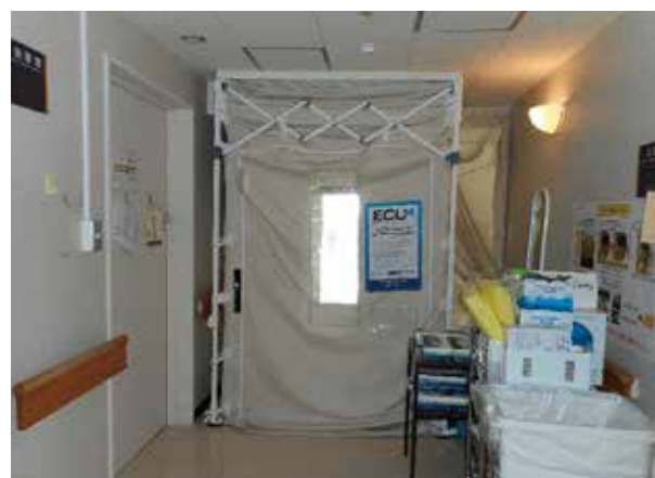
ミンティを廊下に設置して空気の流れを遮断
