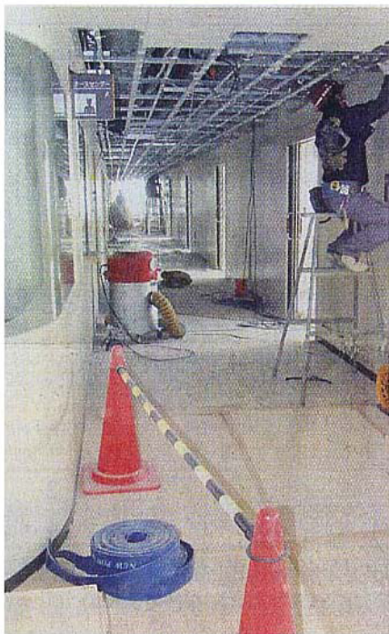
山本組合総合病院で行われている病棟改修
